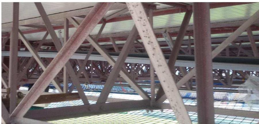
Tale situazione era difficilmente immaginabile in fase di progetto in quanto il fatto che la struttura fosse realizzata in acciaio zincato, protetta da uno strato di vernice, per quanto consunto, e protetta altresì dalla copertura faceva presupporre uno stato di conservazione generale soddisfacente, nonostante la struttura avesse oltre 30 anni.
